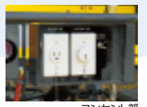
コンセント部
