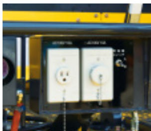
コンセント部
