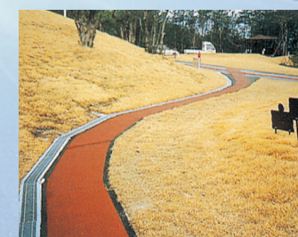
■ ゴルフ場カート道
