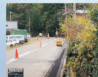
■ 通信管理設復旧工事
