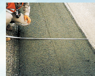
■ わだち掘れ処理
