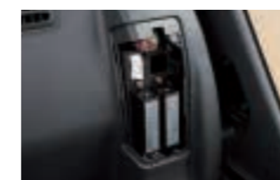
シート後方に集中配置したヒューズボックス
