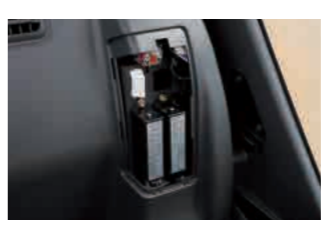
シート後方に集中配置したヒューズボックス
