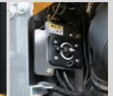
バッテリー遮断スイッチ(点検カバー内)
