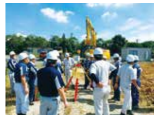
ICT建設機械を使った実演研修
