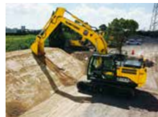
掘削、床付、法面整形といった3Dマシンコントロールの研修
