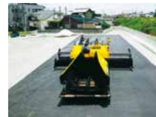
アスファルトフィニッシュでの3Dマシンコントロールの研修
